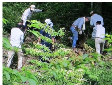
イノシシ防護柵取付作業
