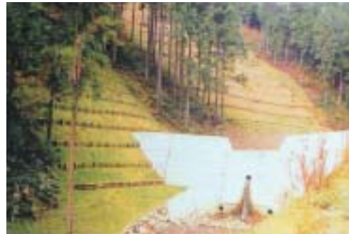
防災の森づくり 谷止工 (鹿野町)
