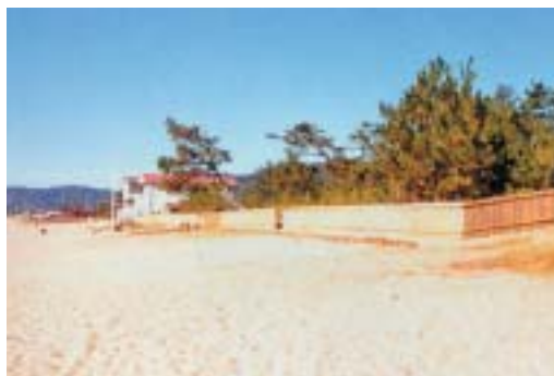
保安林改良 静砂垣・植栽工の設置（光市）
